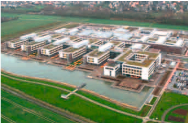
Mit 864 Betten wurde das akademische Lehrkrankenhaus der Medizinischen Hochschule Hannover nach aktuellen medizinischen und betriebsorganisatorischen Konzepten geplant.
