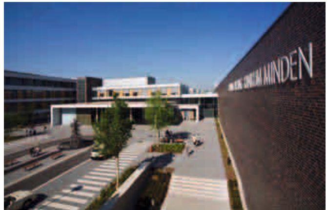
Die Augenpraxisklinik Minden ist Fachabteilung am Johannes Wesling Krankenhaus, einem der größten und modernsten Klinik-Neubauten Deutschlands.
