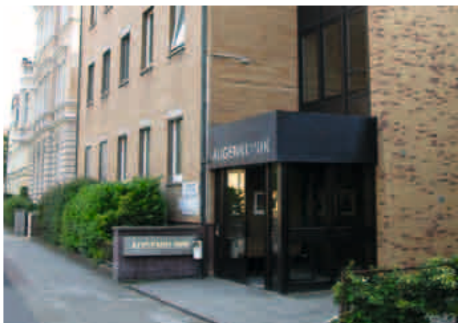
Die Augenklinik Dr. Hoffmann wird vom Urenkel, dem heutigen Mitbesitzer, in fast 120-jähriger Familientradition geführt. Der 1983 modernisierte Neubau entstand 1949, nachdem das ursprüngliche Klinikgebäude im zweiten Weltkrieg vollständig zerstört wurde.
