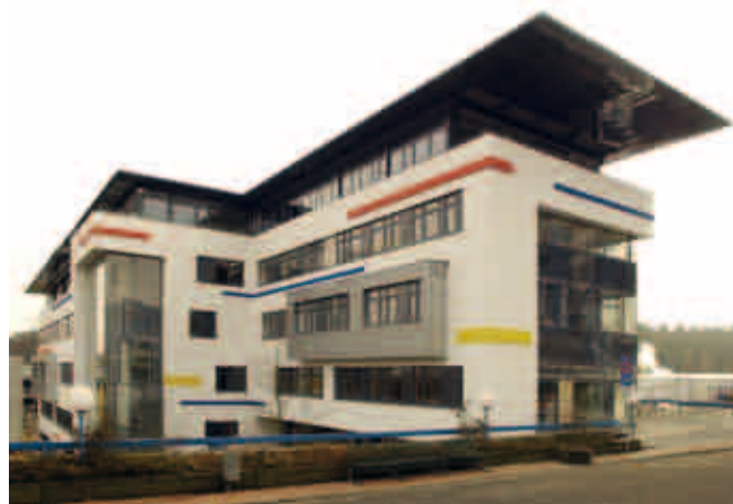
Zentrum für Augen Chirurgie am Klinikum Bamberg – Poliklinik, ambulantes OP-Zentrum und Augenklinik auf einer Ebene auf 1.000 Quadratmetern.
