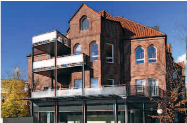
Die Augenärzte Gemeinschaftspraxis am Domhof erstreckt sich über 3 Etagen. Das Entree wurde 2007 an den Bedarf älterer und behinderter Patienten angepasst.
