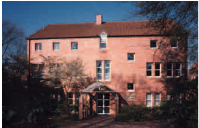
Die Augenklinik Ahaus ist malerisch in die Vorburg des barocken Ahauser Wasserschlosses eingebettet.
