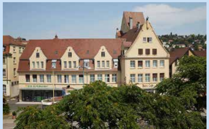
Der neue Standort der Augen-Praxis-Klinik Esslingen im denkmalgeschützten Gebäude der Alten Feuerwache Esslingen.
