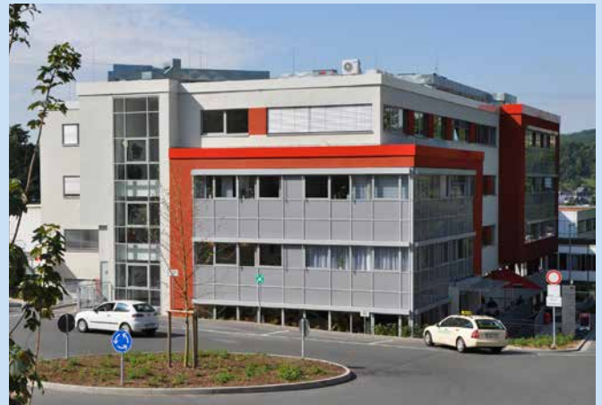
Die Augenklinik Dillenburg am neuen Standort im Ärztehaus in der Nähe des Dillenburger Krankenhauses.
